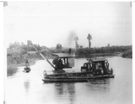
プリストマンバケット浚渫船
